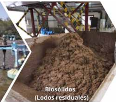
Planta de tratamiento de aguas residuales (PTAR)
