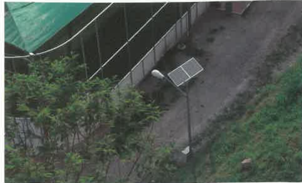
Figura 2. Fotografía de celdas solares acopladas a una lámpara
