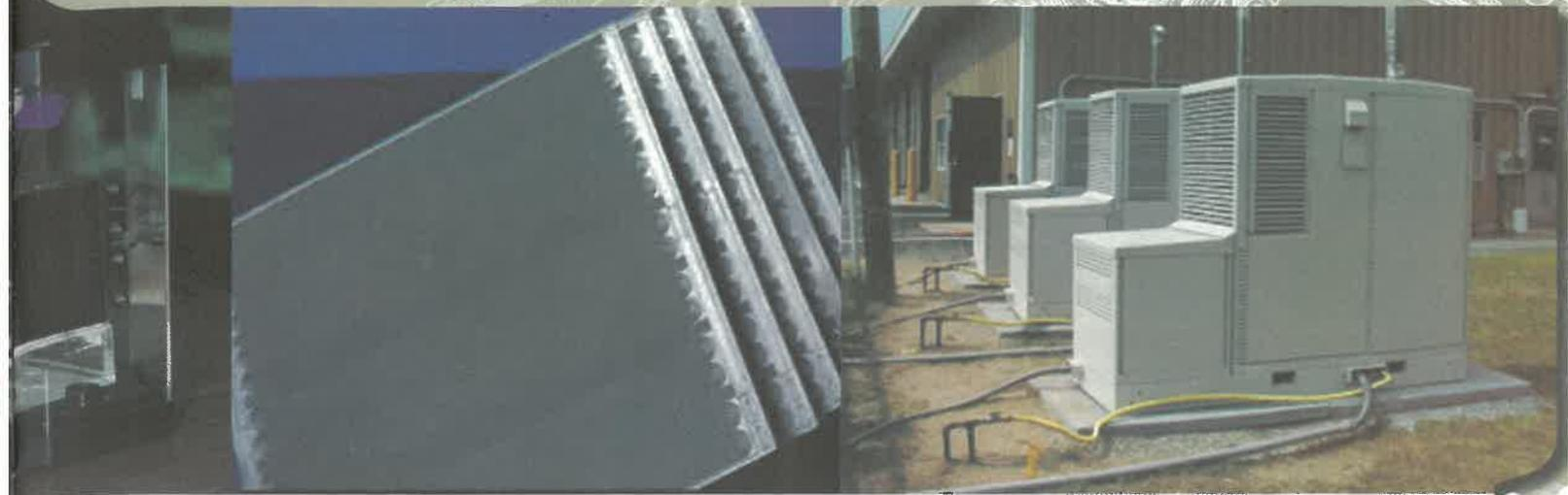
Una monocelda genera de esta manera un voltaje no mayor a 0.7 V. Después, un cierto número de monoceldas conectadas eléctricamente en serie proporciona el voltaje y la potencia solicitados, este elemento se denomina apilamiento de celdas (fig. 3).
