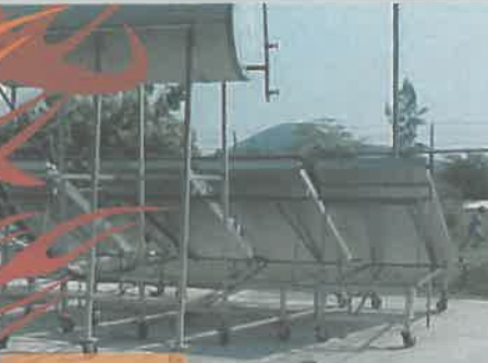
Vista parcial del sistema de refrigeración solar termoquímico Cloruro de bario - amoníaco para la fabricación de hielo
